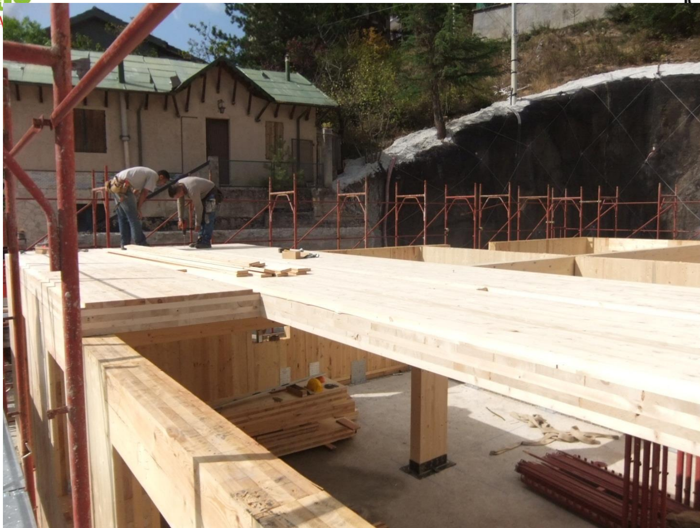
FISSAGGI SOLAIO – PANNELLO VERTICALE www.idsingegneria.it
