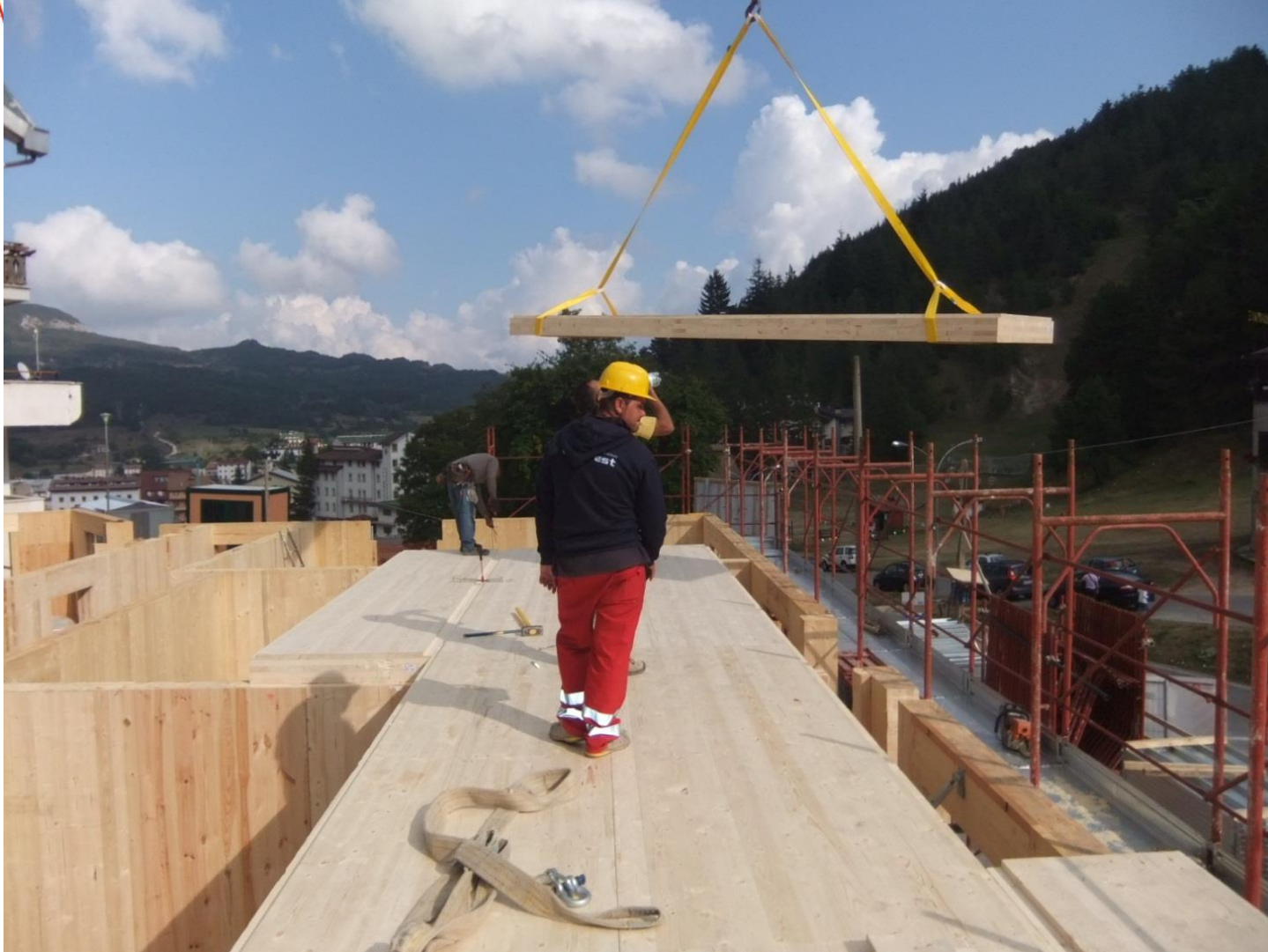
POSIZIONAMENTO DELLE LASTRE SOLAIO
